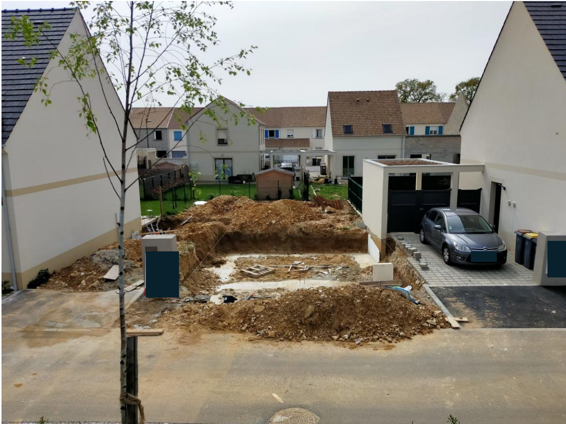
Figure 18 : Chantier dans la ZAC des Champs Verts, grande couronne parisienne. Lorsque les rythmes de commercialisation varient, le chantier devient un élément constitutif du quotidien. Source : Jeunehomme, 2022.
