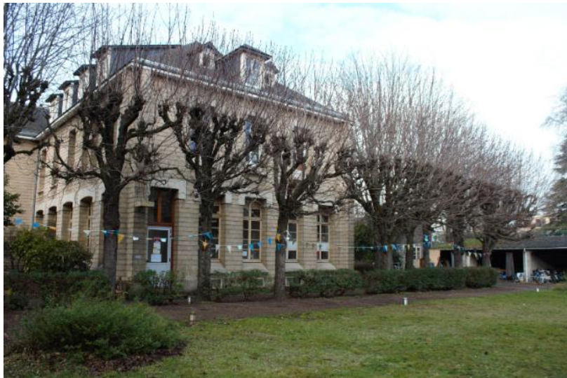
Vu du couvent Reille, photographie personnelle réalisée le 20 janvier 2022.
