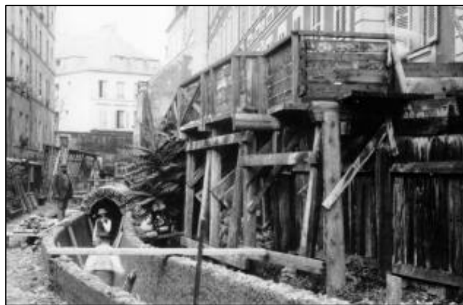
Figure 4 : Travaux de canalisation dans le 5 e arrondissement. Source : APUR, « La Bièvre », 2001.
