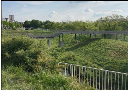
Figure 7 : Pont piéton traversant la Bièvre
